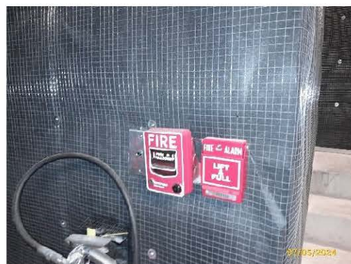
อุปกรณ์ส่งสัญญาณอัคคีภัยแจ้งเหตุด้วยมือ
